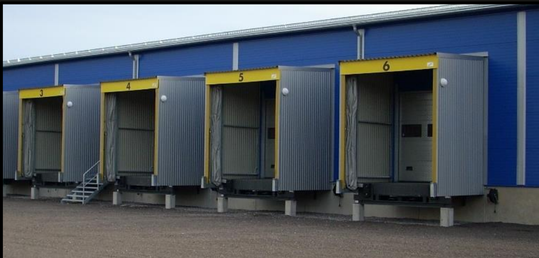
UBS 2400-vädertätningar monterade på lasthus
